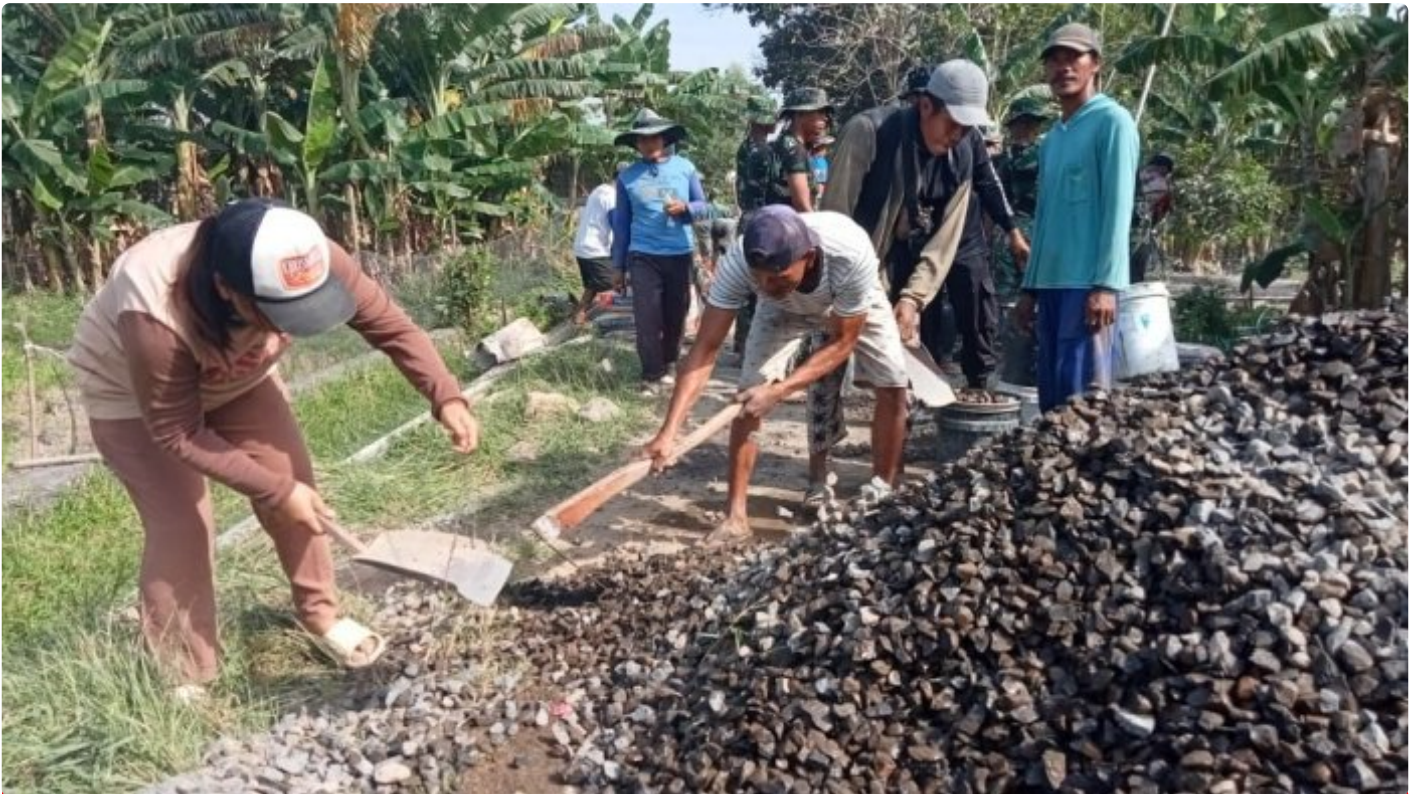
Antusias Warga Cangkring Dalam Pengeroran Jalan Sasaran TMMD
