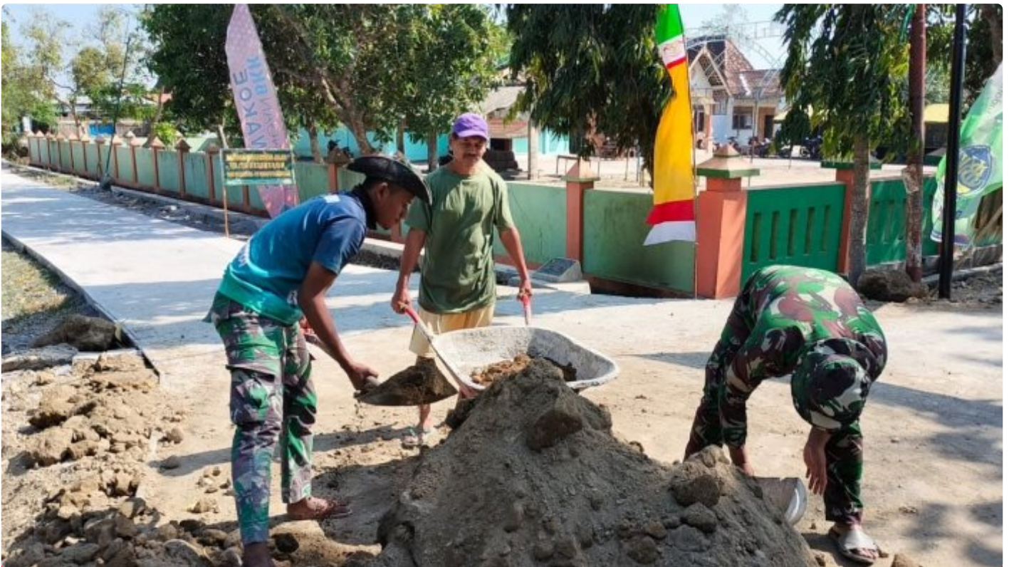
Satgas TMMD Reg 117 Kodim 0717/Grobogan Melaksanakan Finishing Jalan Dengan Pembereman
